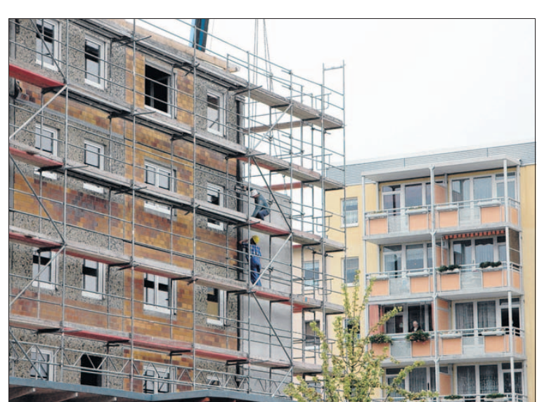
Der Stadtumbau hält die Parkseite des Ostseeviertels seit 2004 in Atem, über 60 Millionen Euro werden von WVG und WGG investiert.
